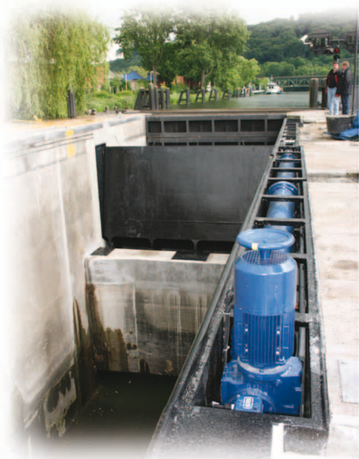
Actionneur d'une vanne à segment, type K1R9 SWB, course = 5500 mm
