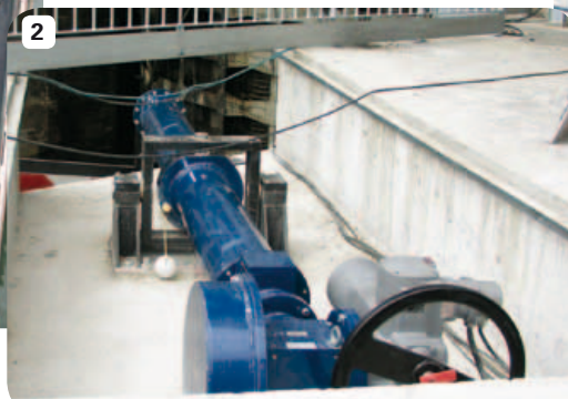
[1]-[3] Actionneur de porte K1R9 SWB avant montage sur cardan en option, pour une écluse et sur une application de porte de barrage
